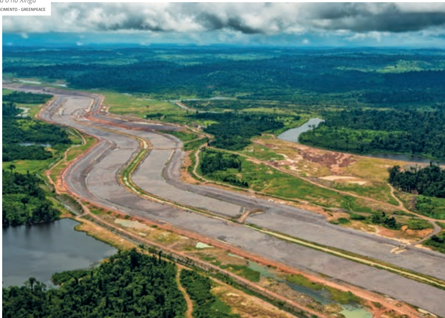
Construção do canal de 20 km de comprimento que desviará o rio Xingu
