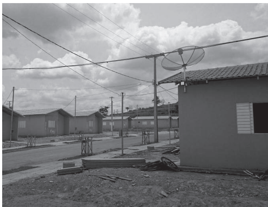
Siedlung Laragera in Altamira Foto: Uta Grunert
