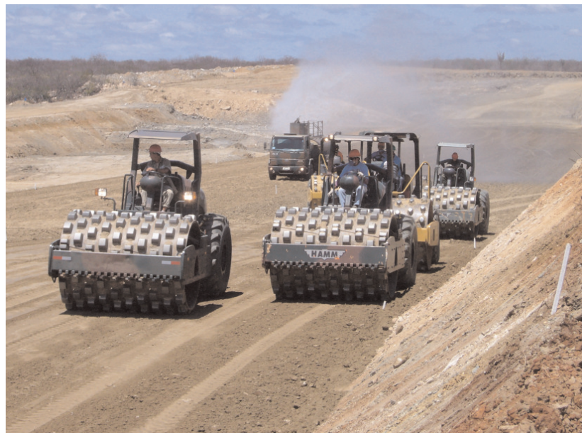
Foto: Thomas Bauer - Baustelle in Cabrobó (Pernambuco)
