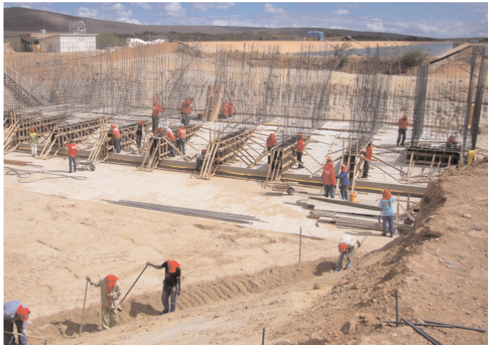
Bau von Bewässerungskanälen in Irecê
